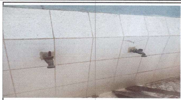
Foto 2: Red de agua potable Sustitución de llave de chorro
