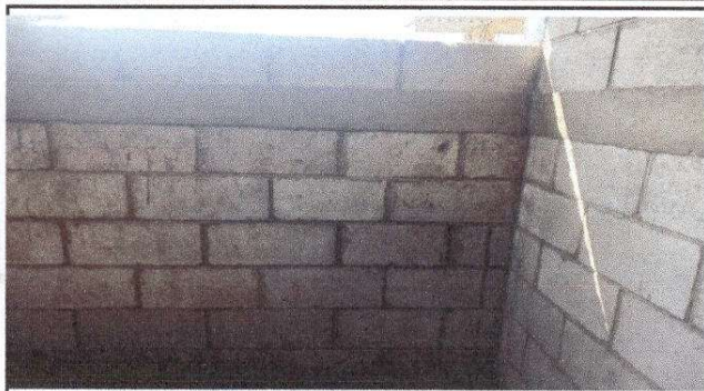
Foto 1: Pintura en muros de contención Pintura en muros exteriores e interiores
