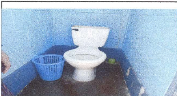
Foto 3: Red de agua potable Sustitución de inodoro
