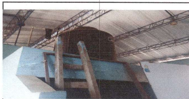
Foto 4: Red de agua Potable Reparación y mantenimiento de cisternas / depositos de agua
