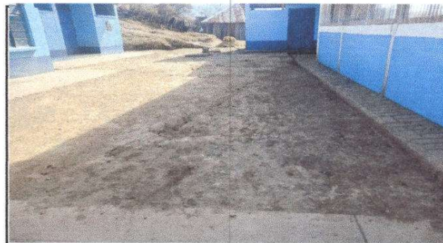
Foto 4: Piso reparacion de piso de concreto
