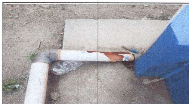
Foto 6: Piso sustitución de bajada de agua pluvial PVC 3
