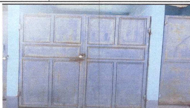
Foto 2: puertas de metal mantenimiento a estructura( lijado, aplicación de pintura)
