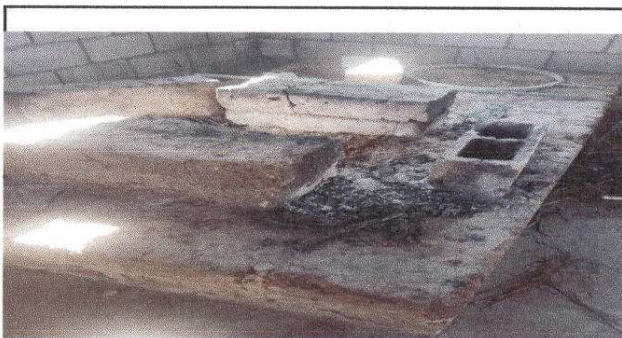
Foto 5: Reparacion de cocina Mantenimiento a estufa rural
