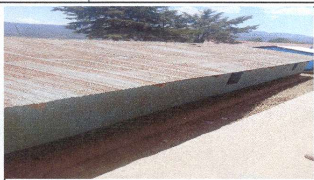
Foto 1: Cubierta de lamina. Sustitución de lamina por lamina troquelada alucin calibre 26
