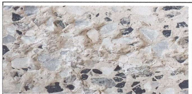
Foto 5: Piso sustitucion de piso ceramico
